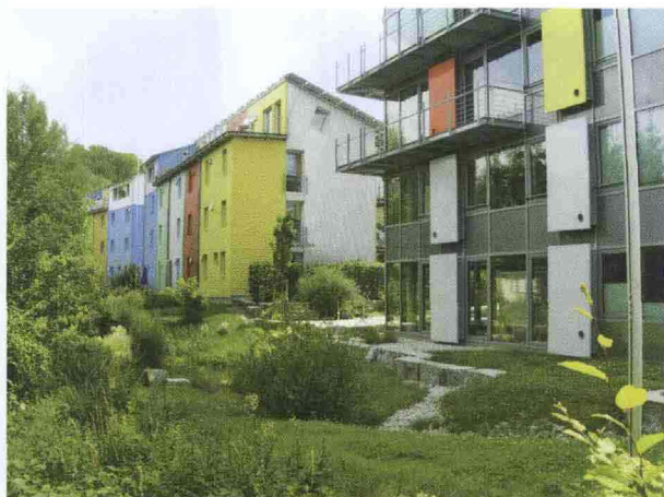
LA CITTÀ TEDESCA DI FRIBURGO HA FATTO RIVIVERE UN VECCHIO SITO MILITARE CREANDO L'ECOQUARTIERE DI VAUBAN
