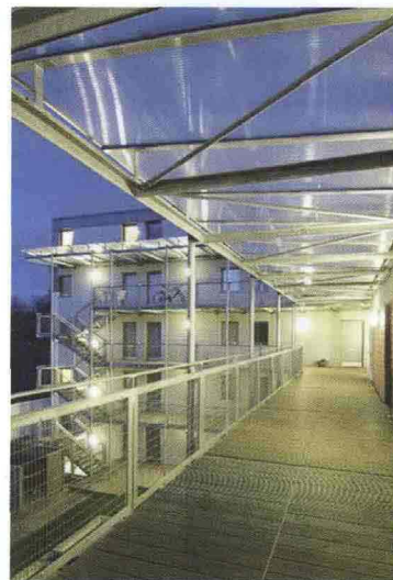
LA PASSERELLA DI ACCESSO AGLI APPARTAMENTI DEL CHORLTON PARK, A MANCHESTER
