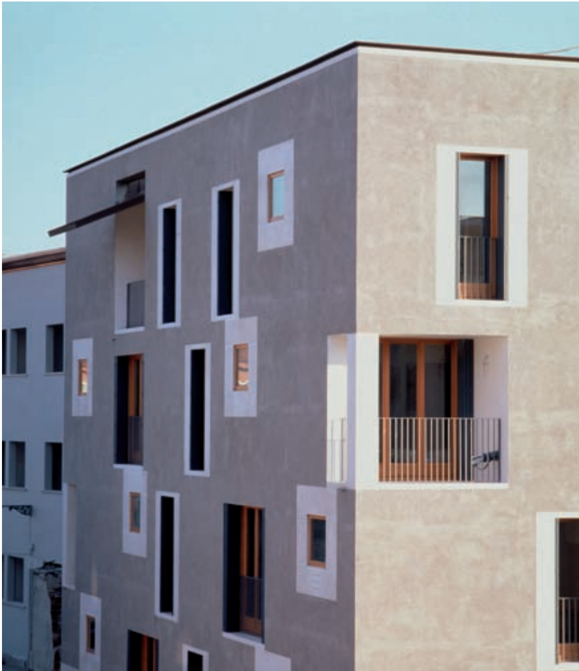
La disposizione irregolare delle finestre segue la distribuzione planimetrica degli appartamenti e li apre alla vista dell'abside del Redentore e dei canali.
