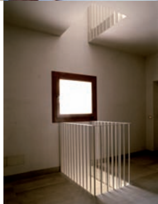
I pianerottoli di distribuzione agli appartamenti con la finestra allineata al filo interno dei muri che affaccia sulla corte e gli squarci nei solai con funzione di pozzi di luce.
